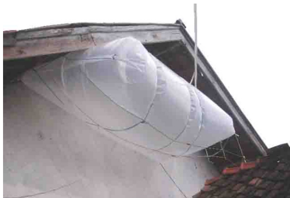
Gambar 5. Contoh Rumah dengan Penampungan Gas yang Terbuat dari Plastik
