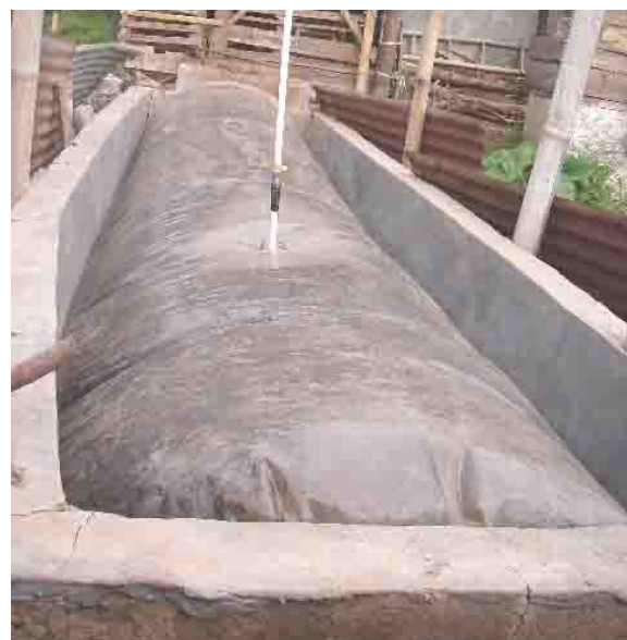
Gambar 4. Reaktor Biogas yang Terbuat dari Plastik
