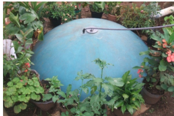
Gambar 3. Reaktor Biogas yang Terbuat dari Fibber
