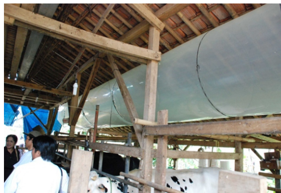
Gambar 6. Contoh Kandang Sapi dengan Penampungan Gas yang Terbuat dari Plastik
